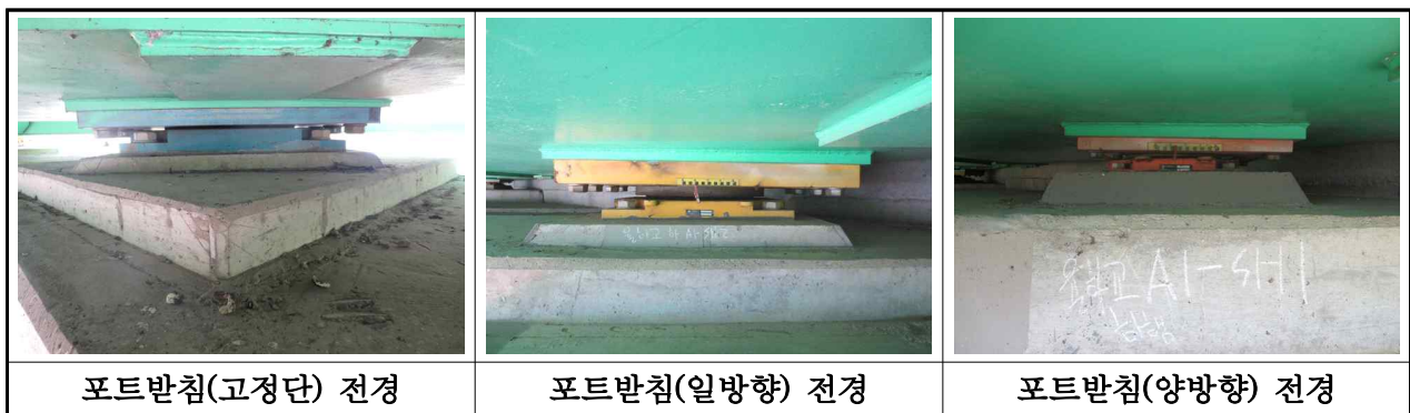
【사진 3.3.11】 교량받침 전경(부산)
