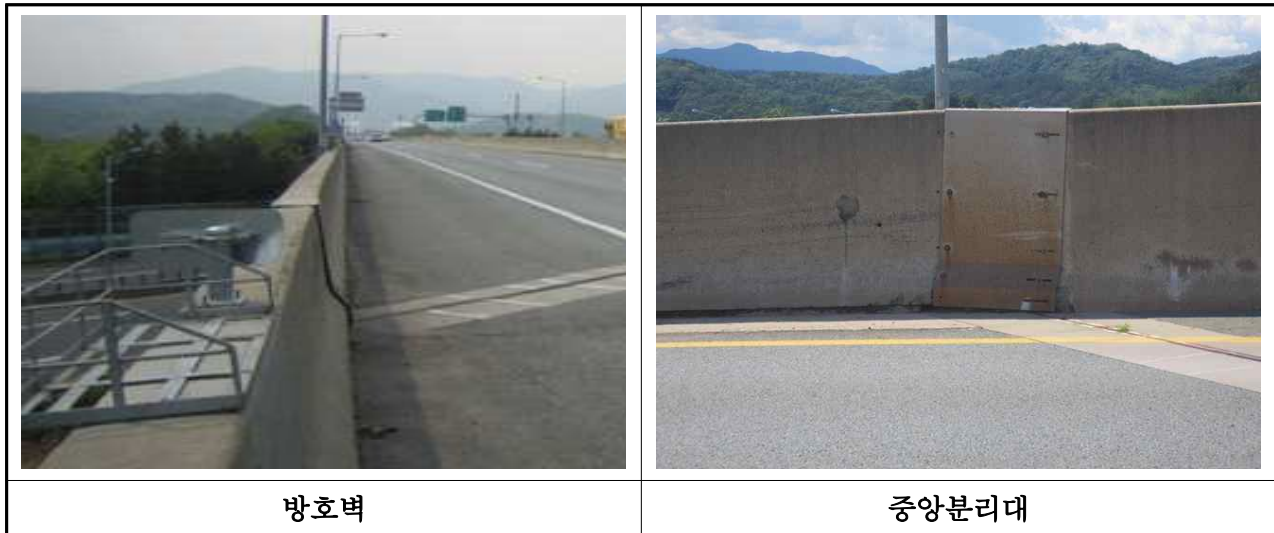
【사진 3.2.21】 난간 및 연석 전경(대구)
