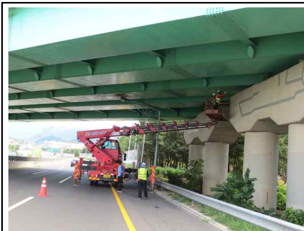
고소작업차를 이용한 조사
