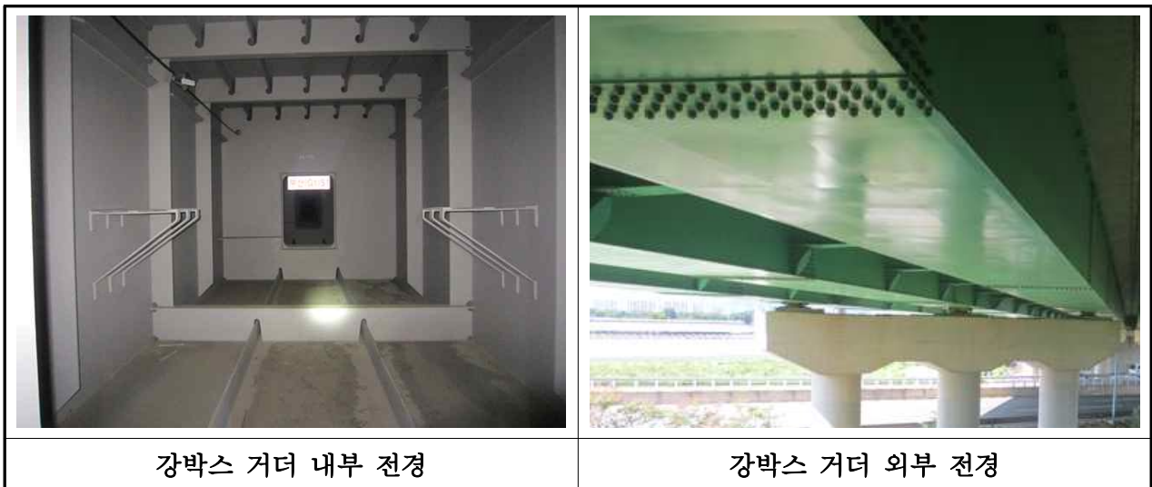
【사진 3.3.3】 강박스 거더 전경(부산)
