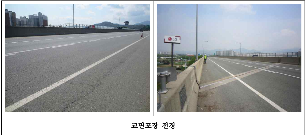
【사진 3.3.16】 교면포장 전경(부산)
