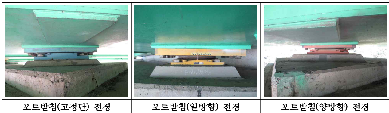
【사진 3.2.11】 교량받침 전경(대구)
