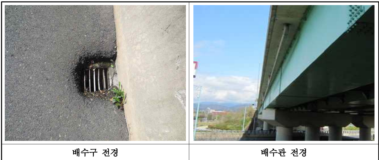
【사진 3.3.18】 배수구 및 배수관 전경(부산)
