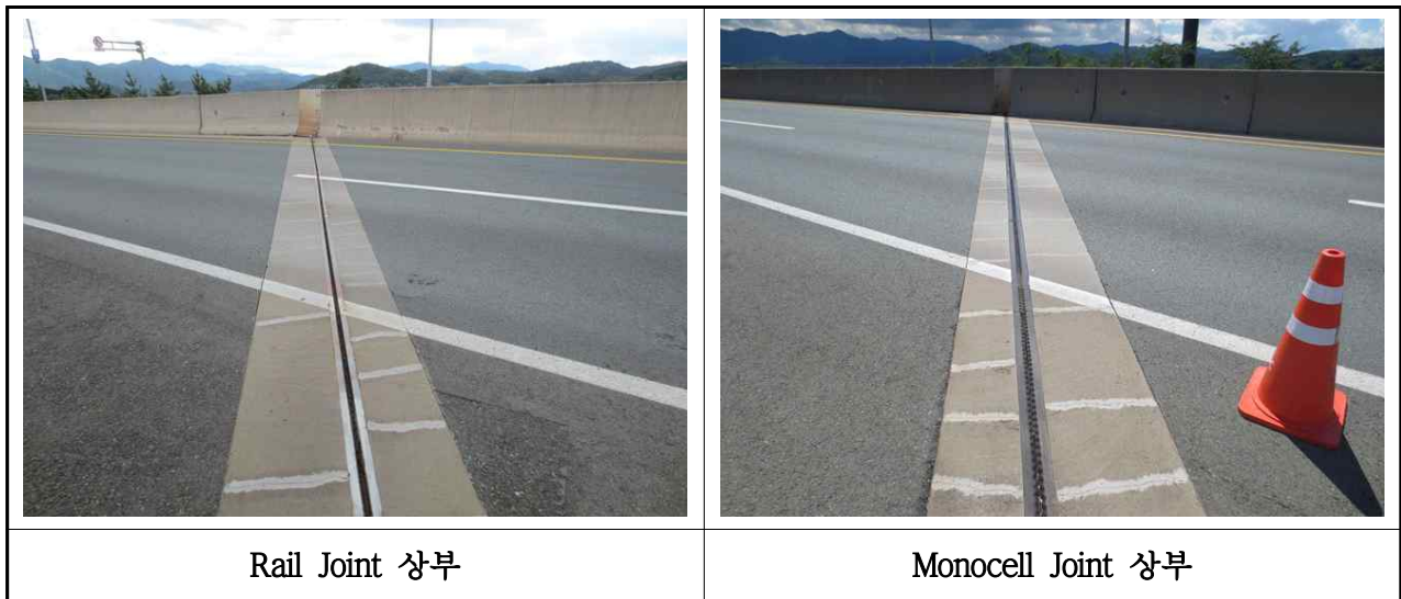
【사진 3.2.14】 신축이음장치 전경(대구)
