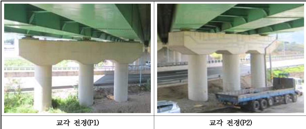
【사진 3.3.9】 교각 전경(부산)
