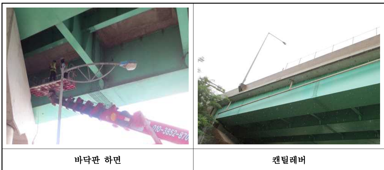
【사진 3.2.1】 바닥판 전경(대구)
