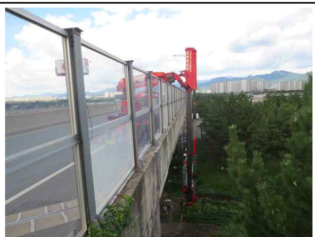
교량점검차(굴절차)를 이용한 조사
