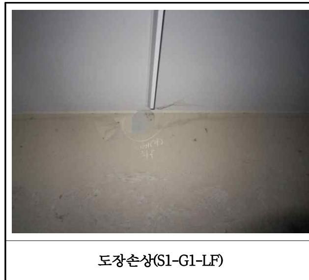
【사진 3.3.4】 강박스 거더 내부 손상현황(부산)
