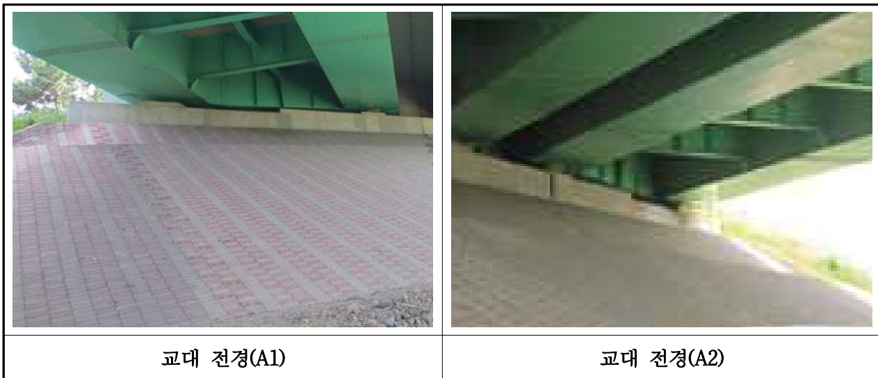
【사진 3.2.7】 교대 전경(대구)
