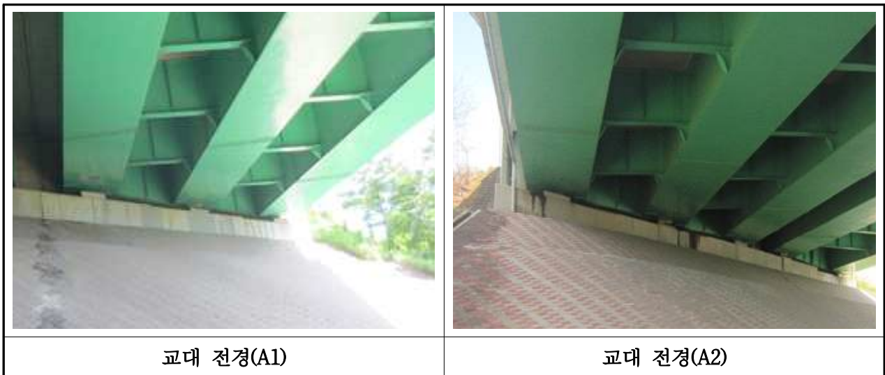
【사진 3.3.7】 교대 전경(부산)
